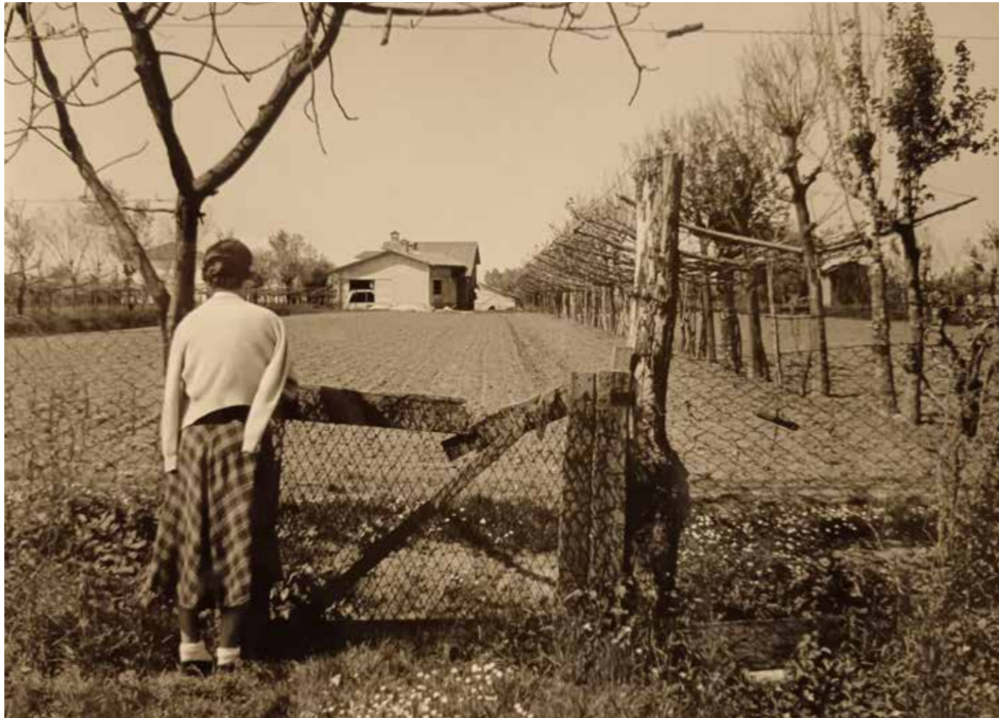
Raffaella Ghigi, di spalle, guarda la Villa in costruzione. (Provenienza Archivio Collezione Ghigi-Pagnani)
